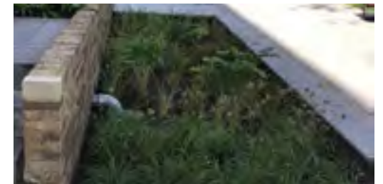
Infiltratie in verlaagd beplantingsvakken. (bron: waterproof Amsterdam)
